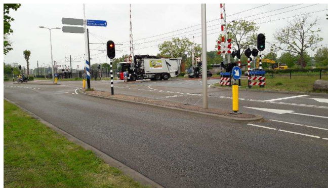
Bevinding 5.5: Aan de noordzijde van het kruispunt ontbreekt een voetgangersroute
