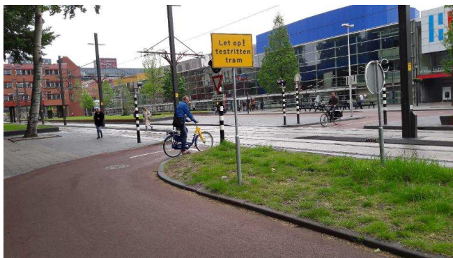
Bevinding 3.7: Padualaan, fietsoversteek direct na krappe bocht, bussen schuin van achteren, waarschuwingslicht is niet tijdig zichtbaar (EA)
