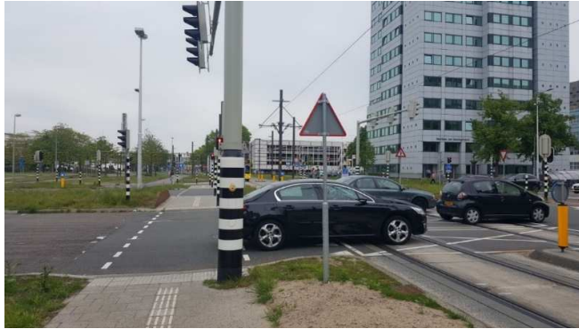
Bevinding 3.5: Bolognalaan, fietsers hebben geen zicht op naderende bus/tram
