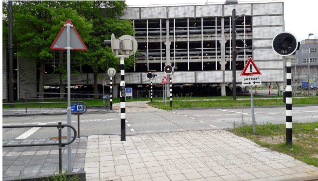
Bevinding 2.11: Oversteek naar parkeergarage, waarschuwing busbaan geeft tekst tram
