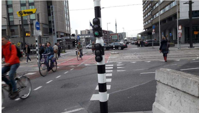
Bevinding 7.2: Voetgangersoversteekplaats aan de spoorzijde ontbreekt (EA)
