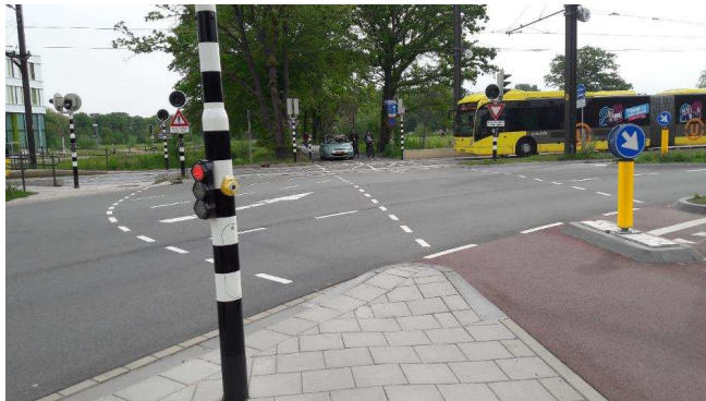
Bevinding 2.8: Complex en onlogisch kruispunt Hoofddijk (EA)
